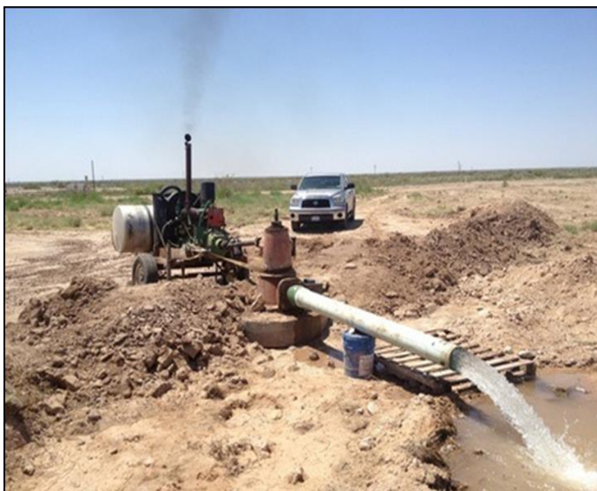
شکل ۹- توسعه چاه با استفاده از پمپ توربینی
