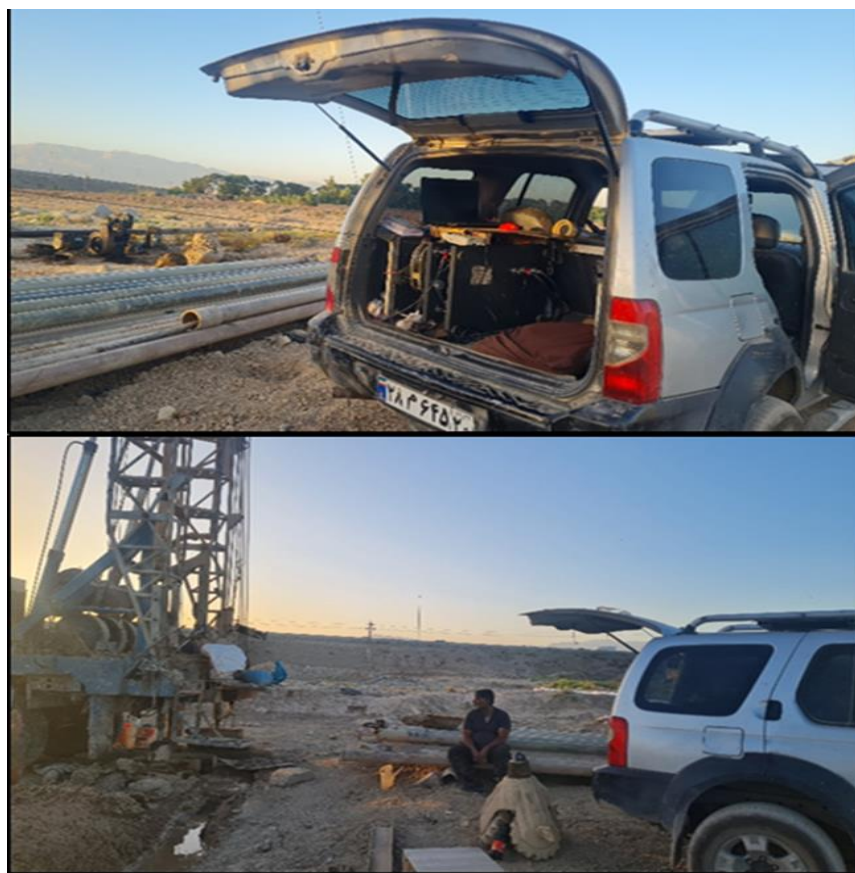
شکل ۱- تصاویر انجام عملیات چاه پیمایی با دستگاه دیجیتالی
